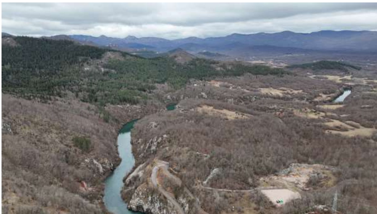
Slika 2.14/4 – Rijeka Lika nizvodno od HE Sklope
