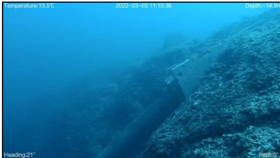
Slika 2.2-6. Lokacija s kritičnom vrijednosti zakrivljenosti cijevi podmorskog ispusta (preuzeto iz: AEQUUM d.o.o., 2022.)
