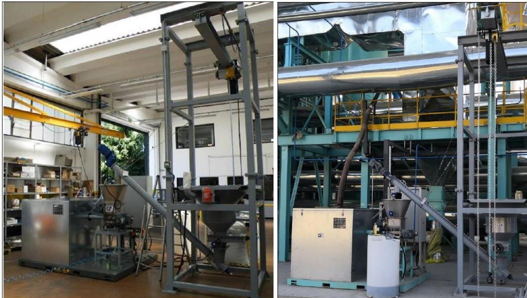
Grafički prikaz 3-5: Prikaz sustava odsumporavanja neposredno prije ugradnje (lijevo) te tijekom redovitog rada (desno)
