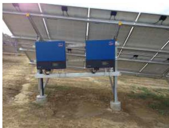
**Slika 2:** Način montaže inverteera na podkonstrukciju
