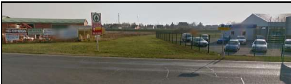
Slika 2.1-2. Pogled na početnu dionicu planiranog zahvata – od spoja na cestu DC53 prema jugu (izvor: Google Earth, 2019.)
