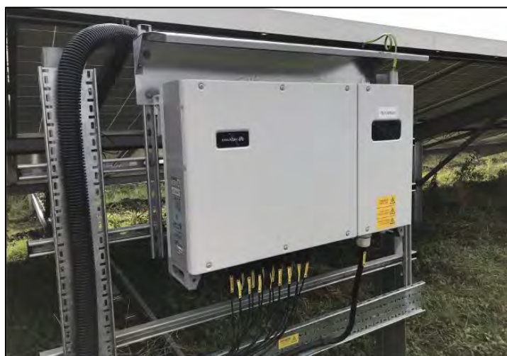
Slika 6. Detalj montaže izmjenjivača na podkonstrukciju
