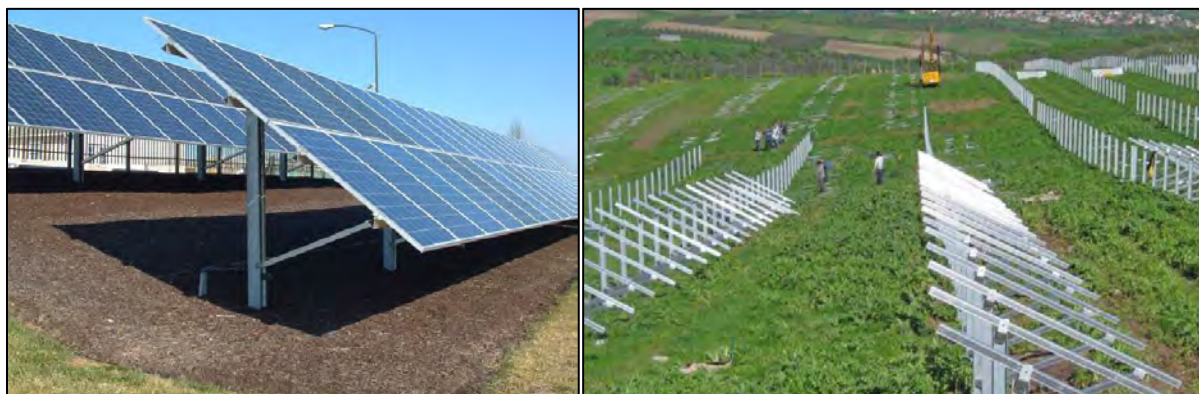
Slika 5. Detalj montaže podkonstrukcije bez temeljenja
