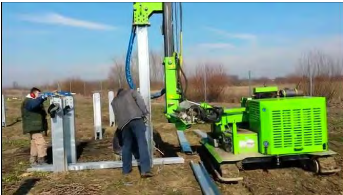
Slika 7. Prikaz stroja za zabijanje stupova u zemlju
