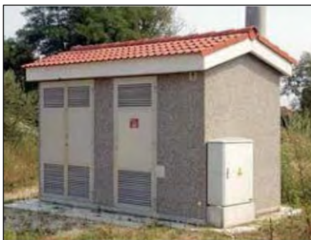
Slika 8. Transformatorske stanice tipa MTS 12(24) (lijevo) i KTS 12(24) (desno)
