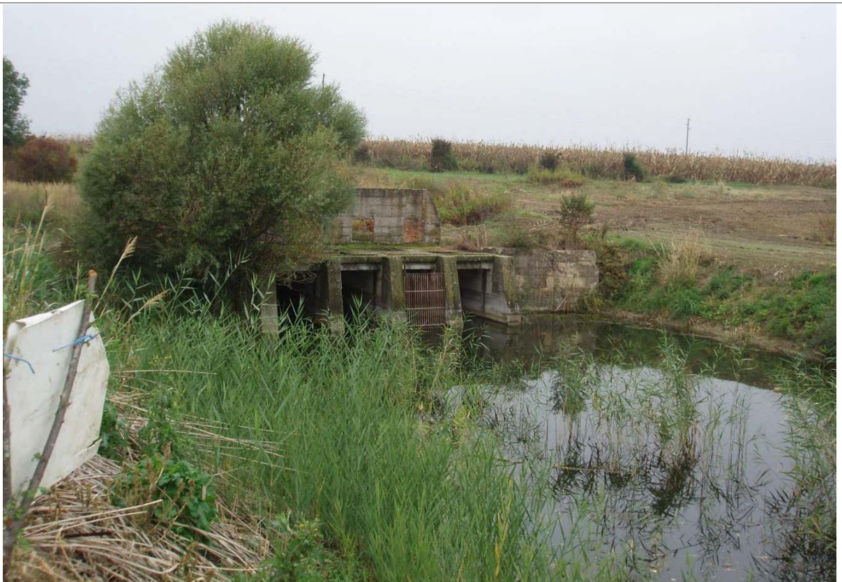
Slika 1.1-3. Lokacija buduće CS Topolje – mjesto izgradnje postolja za pokretnu crpku (Izvor: Idejni projekt sustava navodnjavanja Puškaš, Hidroing d.o.o., za projektiranje i inženjering, 2013., Osijek – foto dokumentacija)
